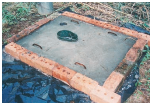
Photo 4-7 : La dalle finalisée à l'intérieur du moule.
