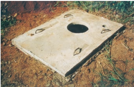
Photo 4-13 : Pose de la dalle de béton
