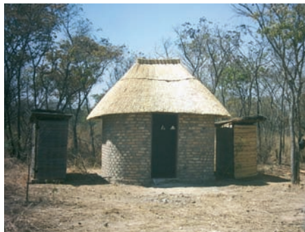
Photo 4-26 : Une Fossa alterna avec une structure permanente en chaume et en briques
