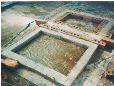
Photo 4-9 : Coffrage de soubassement en briques.
