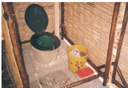
Photo 4-18 : L'intérieur d'une Fossa alterna équipée d'un siège
