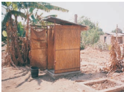
Photo 4-2 : Une cabine mobile avec cadre métallique
