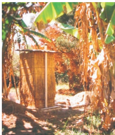
Photo 4-16 : La Fossa alterna avec des murs d'herbes
