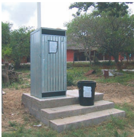
Photo 4-27 : Une Fossa alterna avec une structure métallique
